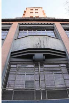
Detalle fachada SSMN desde calle Maruri. Archivo Municipalidad de Independencia.
